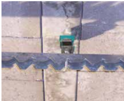
Instalación amortiguadores Akustik + Sylomer® en perfil dentado.
